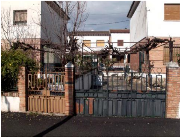
Único lindero lateral restante sin ocupación en parcelas colindantes en el conjunto edificatorio. C/ Rodríguez Haro.
