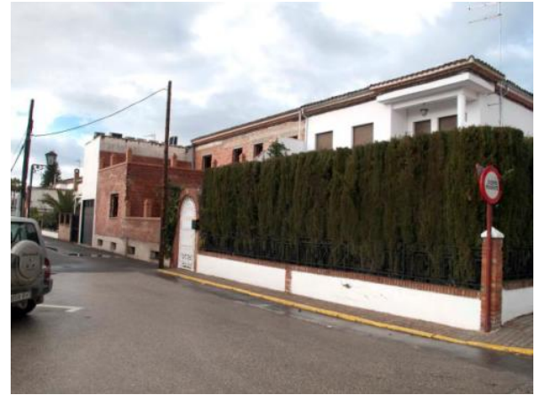
Fachada trasera viviendas pareadas C/ Rodríguez Haro
