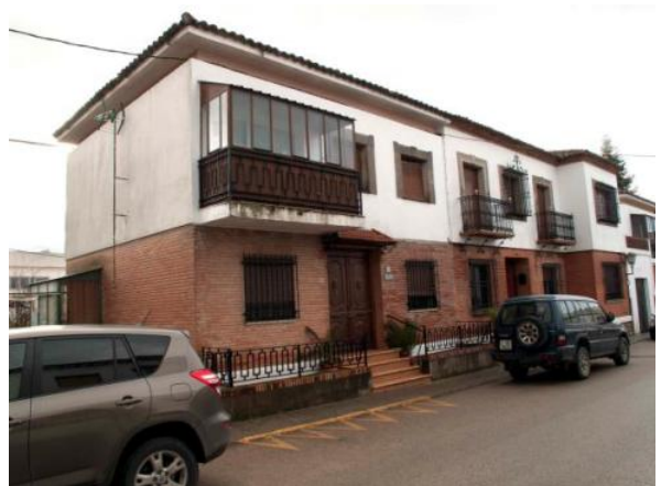
Fachada transformada C/ Madre Mónica
