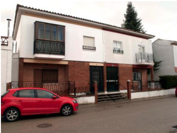
Fachada transformada C/ Madre Mónica
