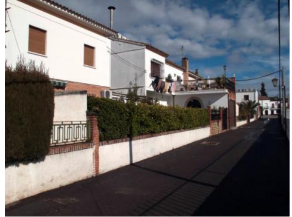
Fachada trasera viviendas pareadas C/ Rodríguez Haro
