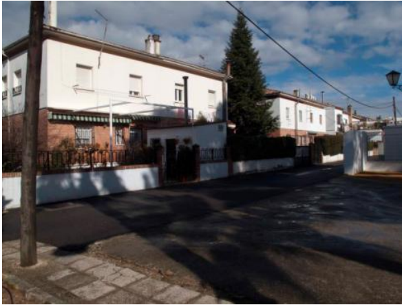
Fachada trasera viviendas pareadas C/ Rodríguez Haro
